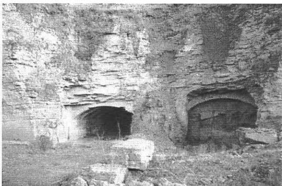
Partie centrale du front de taille des carrières de Glay; on voit distinctement les deux galeries avec les arceaux de soutènement de la voûte (Cliché : M.M.)
