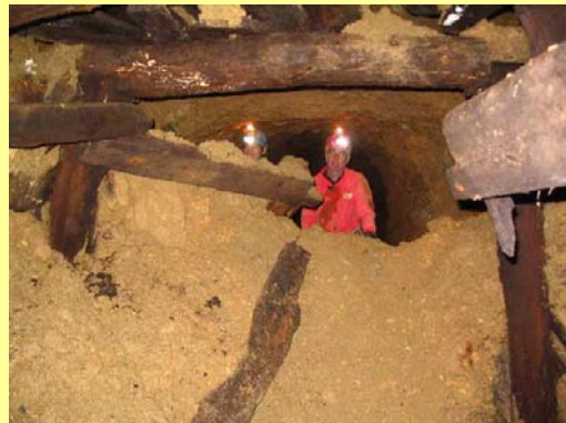
Un passage "craignos" avec des boisages en mauvais état dans la mine de Neyrac (Lozère)
